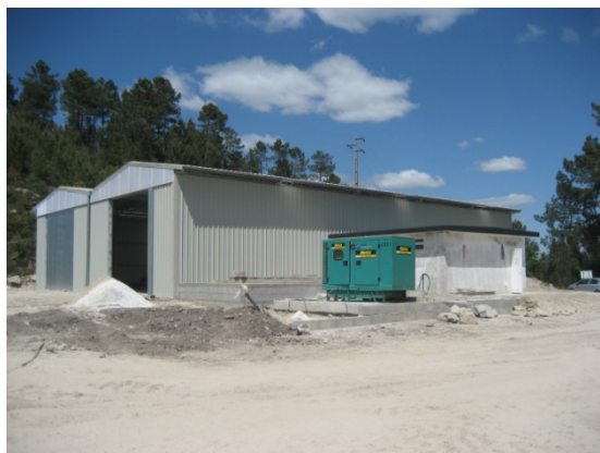
Foto 34: Instalações sanitárias e de armazenamento da pedreira
