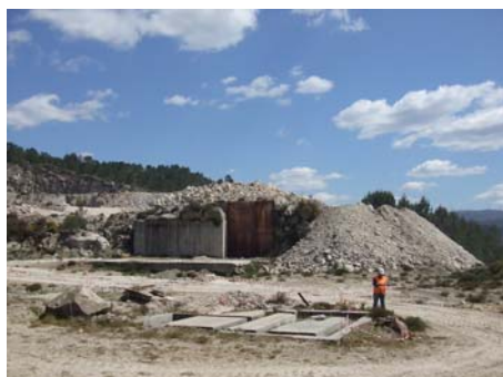
Foto 29: Localização da Central de Britagem
