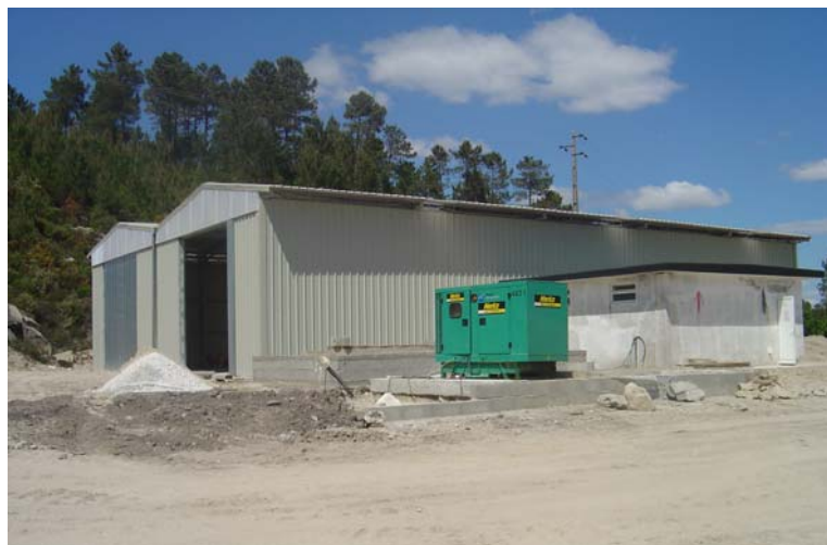
Foto 39: Instalações de apoio à pedreira (armazéns)
