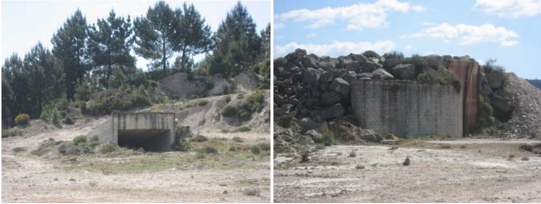
Foto 40: Edificações existentes na pedreira a demolir no fim da exploração
