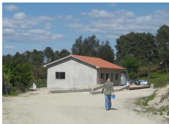
Fotos 35: Instalação fixa de apoio à pedreira
