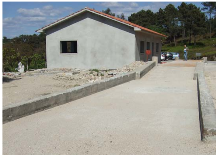
Foto 38: Instalações fixas de apoio da pedreira do Fragoso
