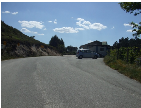
Foto 21: Caminho com pavimento em tapete betuminoso de acesso ao edifício de escritórios da pedreira, que continua depois em terra batida
